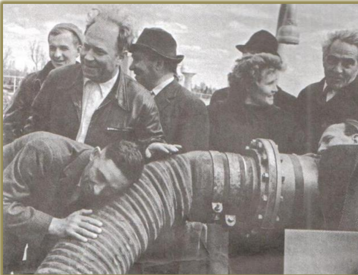
Запуск нефтепровода. Эрвье Ю. Г. (верхний справа). Усть-Балык. 1964 г. .
