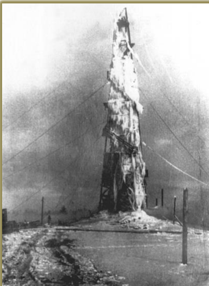
Авария на Берёзовском месторождении
